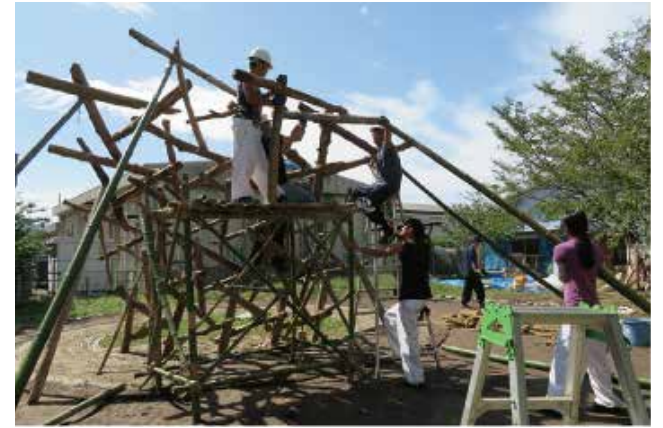
15. 竹で制作した足場で高所作業
