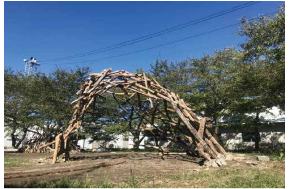
20. 大ドーム構造体
